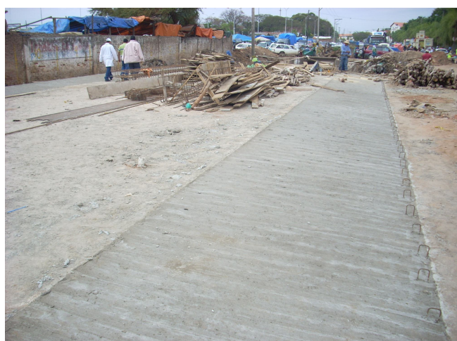
Canal de drenaje despues los trabajos
