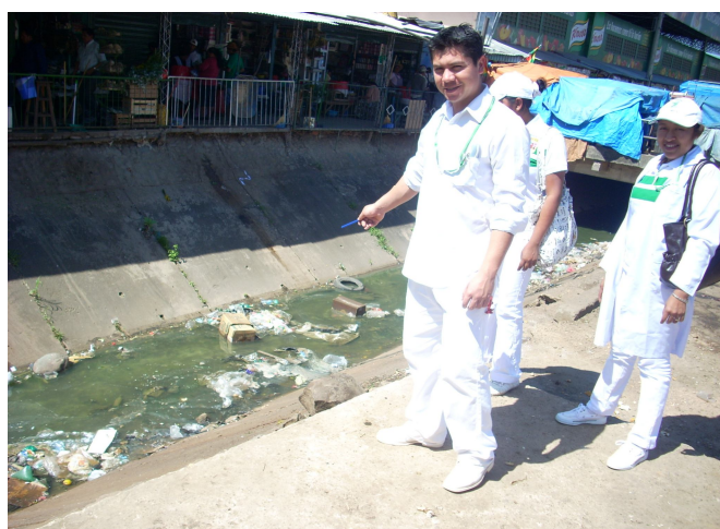
Canal de drenaje antes
